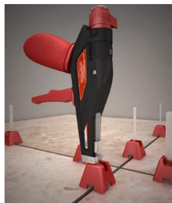
Afb. 3b Met het pistool in STD stand de straps-en-caps aantrekken totdat tegels vlak liggen.
